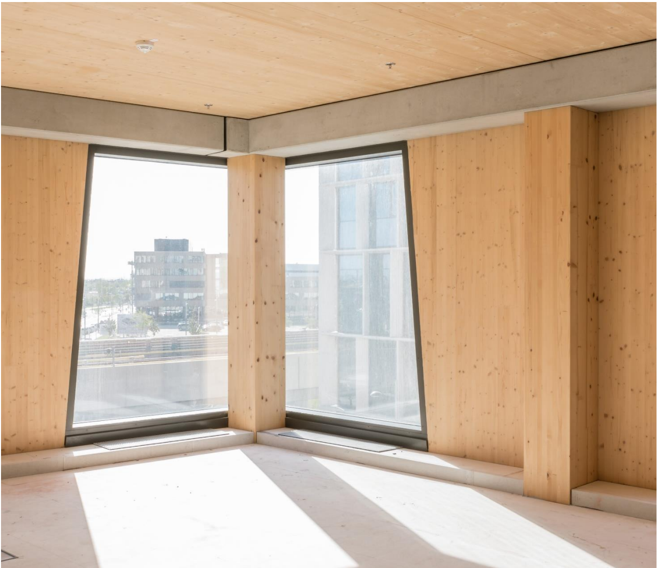
Avec ses 24 étages sur une hauteur de 84 m, le HoHo Vienne est l'un des plus hauts bâtiments en bois au monde. Éléments composites en bois lamellé-collé de la classe de résistance GL32h © Groupe HASSLACHER | cetus.at
