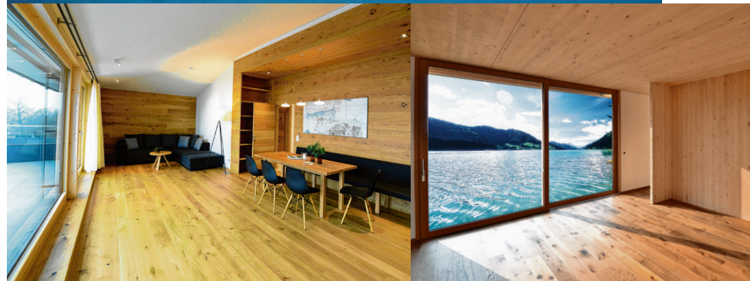
Das Architekturbüro Ronacher in Kärnten schuf ein Bürogebäude mit sechs Ferienwohnungen am Ossiacher See. Vorwiegend wurden Brettsperrholzplatten verwendet, im Innenausbau wurden die Fichtenplatten mit Zirbe und Lärche furniert, die außen liegenden Balkone mit Lärche.
