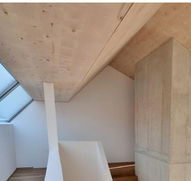
Das Einfamilienhaus Raser in der Oststeiermark kann als Pilotprojekt bei der Verwendung von Laubholz als Brettsperrholz bezeichnet werden. Durch die hohen mechanischen Eigenschaften der Holzart Birke konnten rund 15 % an Volumen eingespart werden. Zudem wurden die Oberflächen mit der Exzellentlamelle versehen, was für fugen- und rissefreie Optik sorgt. Sämtliche Sichtflächen wurden in Birke ausgeführt.
