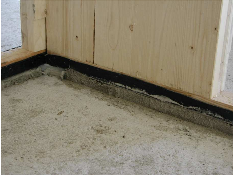
Abbildung 50: Auflagerdetail einer Innenwand
