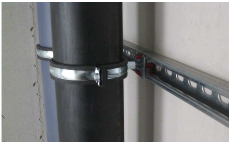
Abbildung 81: Schallschutztechnische Entkoppelung der Rohre
