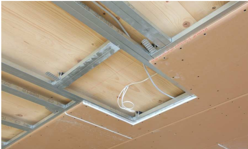
Abbildung 41: Deckensystem mit Schwingbügel und GKF mit guten Schallschutzeigenschaften, Quelle: Firma Knauf
