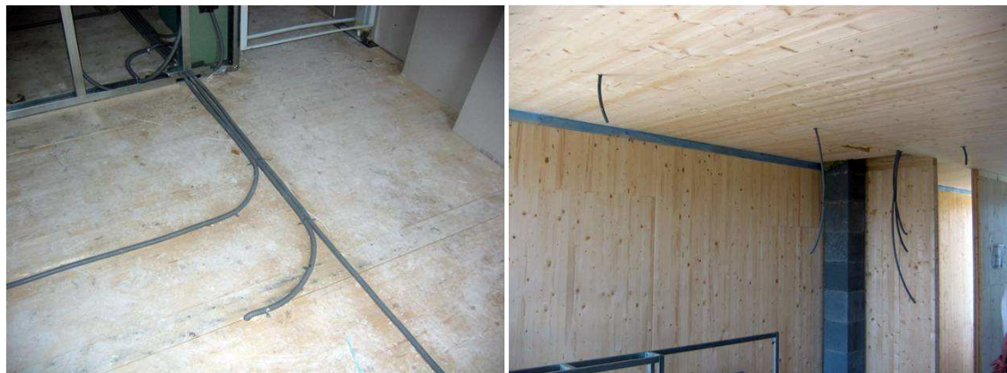
Abbildung 37: E-Leitungsführung bei sichtbarer Brettsperrholzdecke ist luftdicht auszuführen
