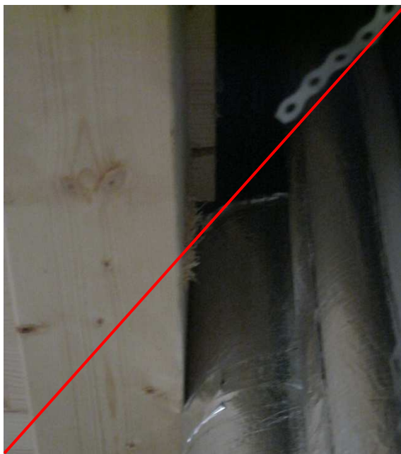
Abbildung 79: fehlerhafte Ausführung: Aufgrund einer nachträglichen Vergrößerung des Schachtes ist schachtinnenseitig keine nichtbrennbare Bekleidung des hölzernen Unterzuges möglich.
