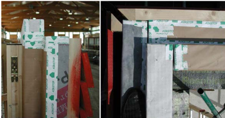
Abbildung 55: Außenwanddecke: links Vorfertigung (Ansicht); rechts Montage (Draufsicht)
