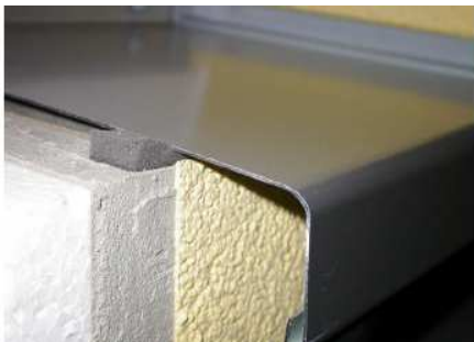
Abbildung 53: horizontale Fuge unter der Fensterbank zur Fassadenoberfläche mit diffusionsoffenem Dichtband. Kann auch offen ausgeführt werden. Quelle: [Österreichische Arbeitsgemeinschaft Fensterbank]
