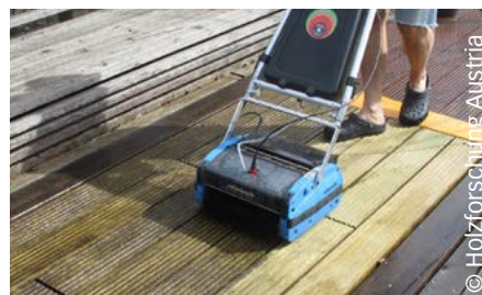
Pulizia delle superfici della terrazza con una spazzolatrice.
