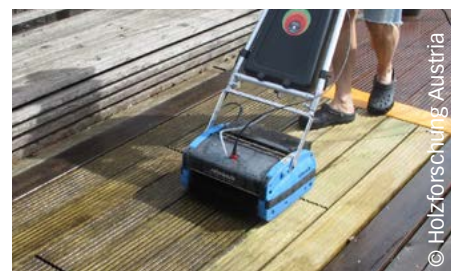
Reinigung der Terrassenoberflächen mittels Bürstmaschine.
