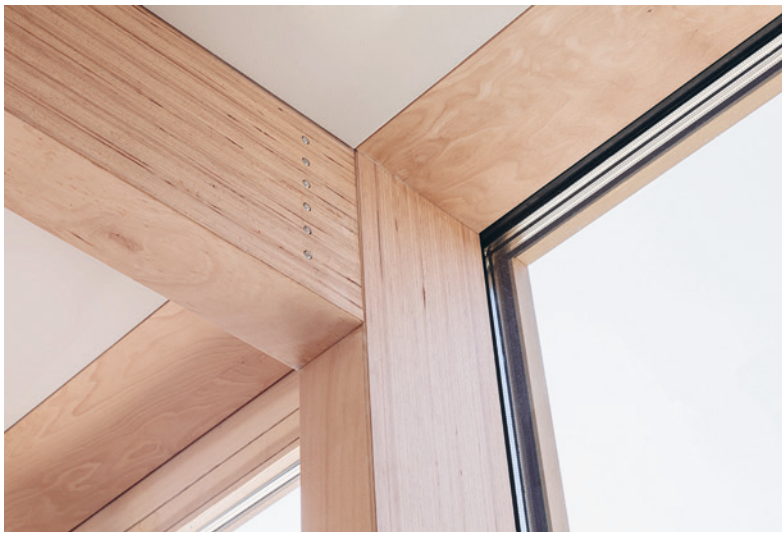
Tischlerei Anton Mohr, Andelsbuch Sichtbare Tragkonstruktion aus BauBuche GI70 Architektur: Andreas Mohr, Tragwerksplanung: merz kley partner ZT GmbH Holzbau: Kaufmann Zimmerei Fotos: Christian Grass
